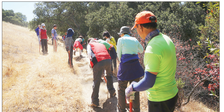
등산로 보수공사 현장 모습
